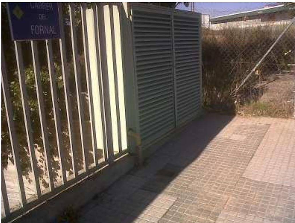
*Foto real del armario donde irá ubicado el equipo de regulación y medida, actualmente hay un regulador A-100 instalado, el regulador y la instalación existente se tendrá que sacar para poder colocar la nueva instalación.*
