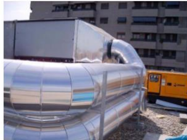
Sistema de calorifugat protegit per una carcassa de xapa d'alumini.
